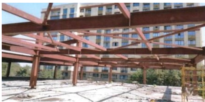
Рис. 2.4 Отдельные демонтированные участки ограждающих конструкций в уровне подвала
