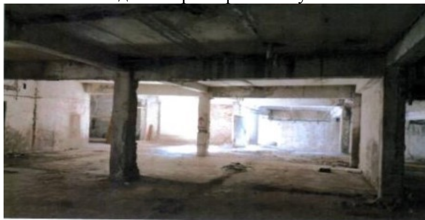
Рис 2.1 Общие виды несущих конструкций двухэтажного здания с подвалом ресторана «Саулет»
