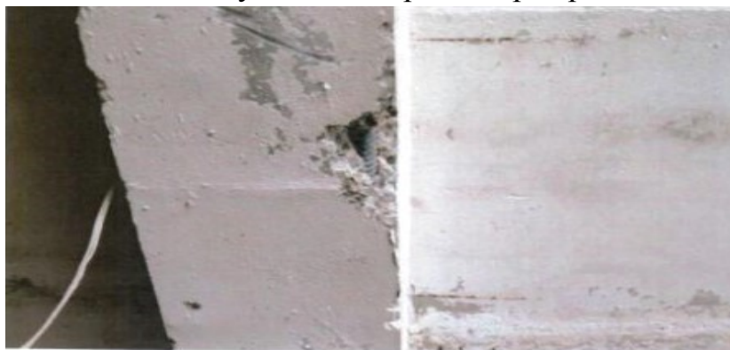
Рис. 2.6 Отдельные участки вскрытия армирования колонн
