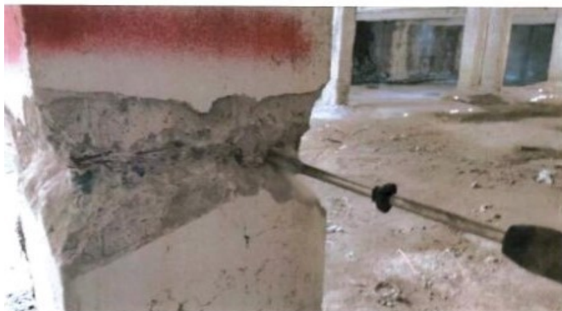
Рис. 2.6 Отдельные участки вскрытия армирования колонн
